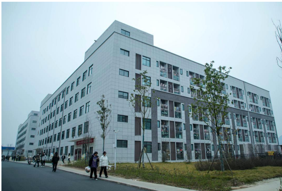
图 42 学院东区 3 栋学生公寓顺利投入使用
